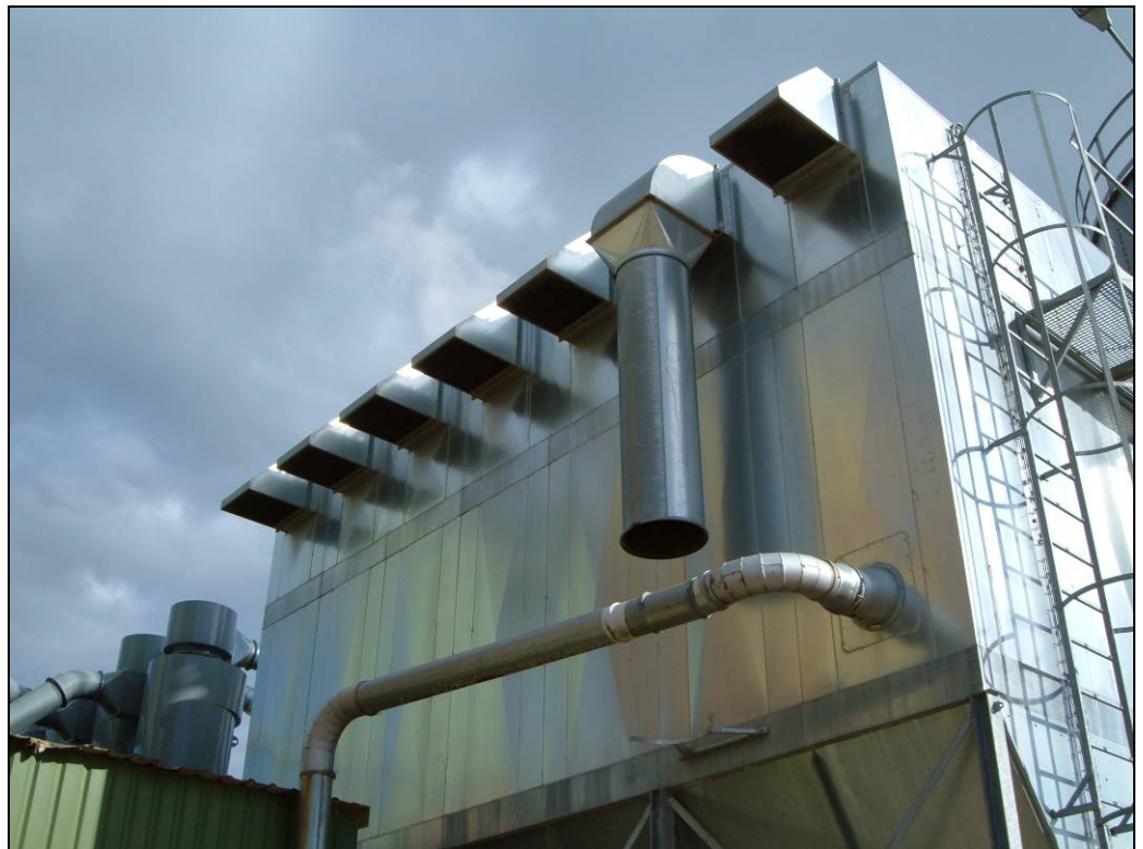
Figur 1. Posefilter på træindustri med 7 firkantede nedadvendte afkast, med et forlænget afkast, hvor der kan udføres målinger. Røret kan flyttes til de andre afkast.
